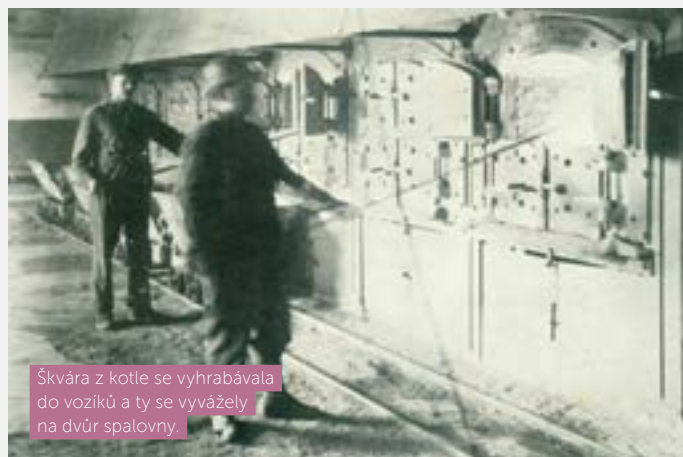
Vyvážení strusky do drtiče, který byl součástí spalovny.
