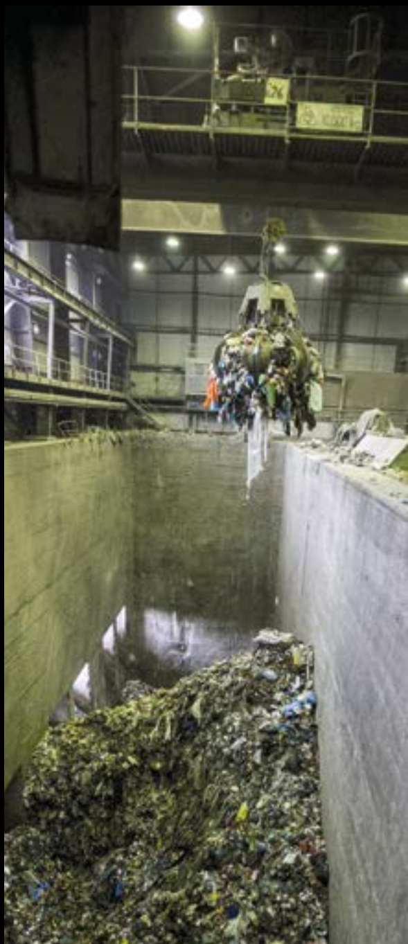
Zásobník odpadu spalovny pojme náklad asi jednoho tisíce popelářských vozů.
