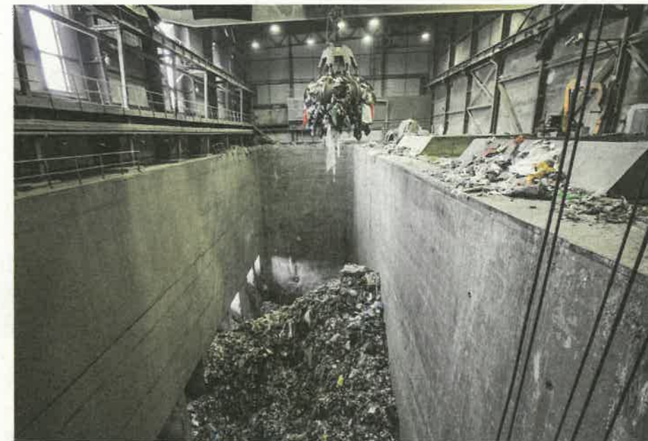
Zcela naplněný bunkr by jednomu kotli vystačil zhruba na týden.
